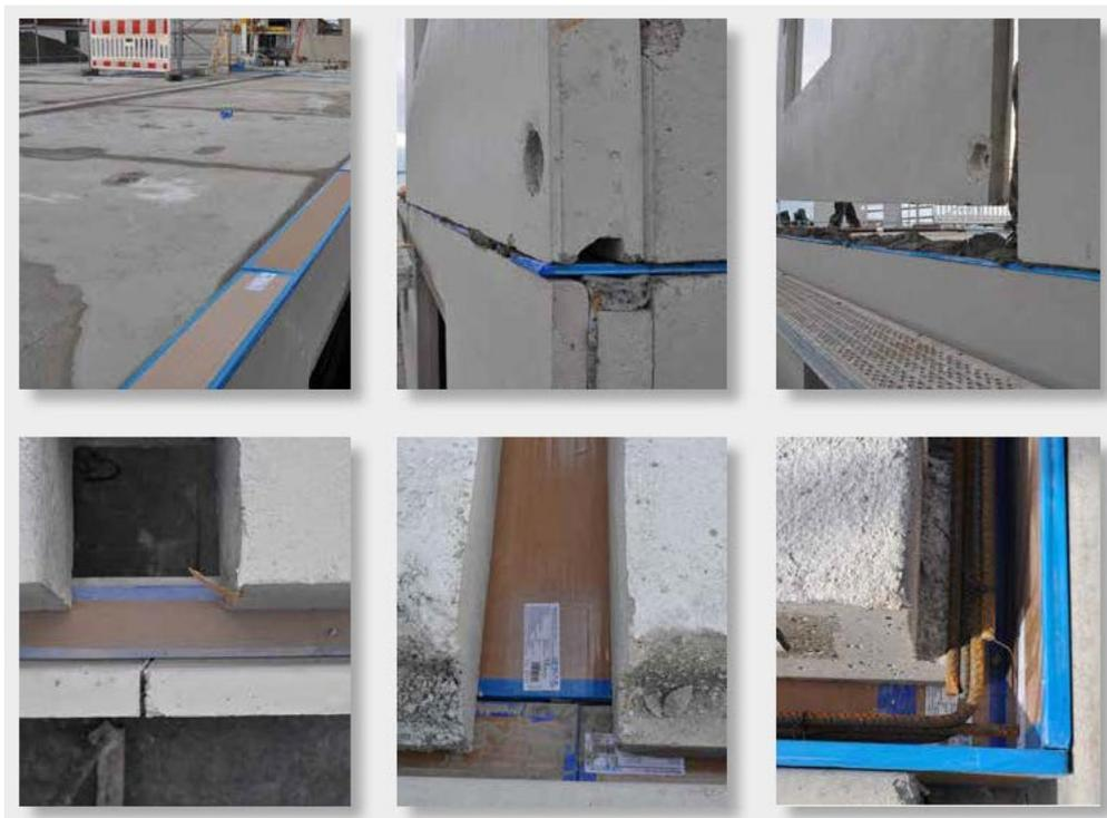
\* Монтаж ламелей Phone Strip на строительной площадке не зависит от погодных условий, однако после завершения дневных работ она, как и деревянные элементы конструкции, должна быть закрыта, чтобы обеспечить защиту от атмосферных воздействий.
